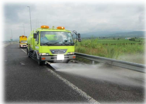
～路面の清掃作業～
